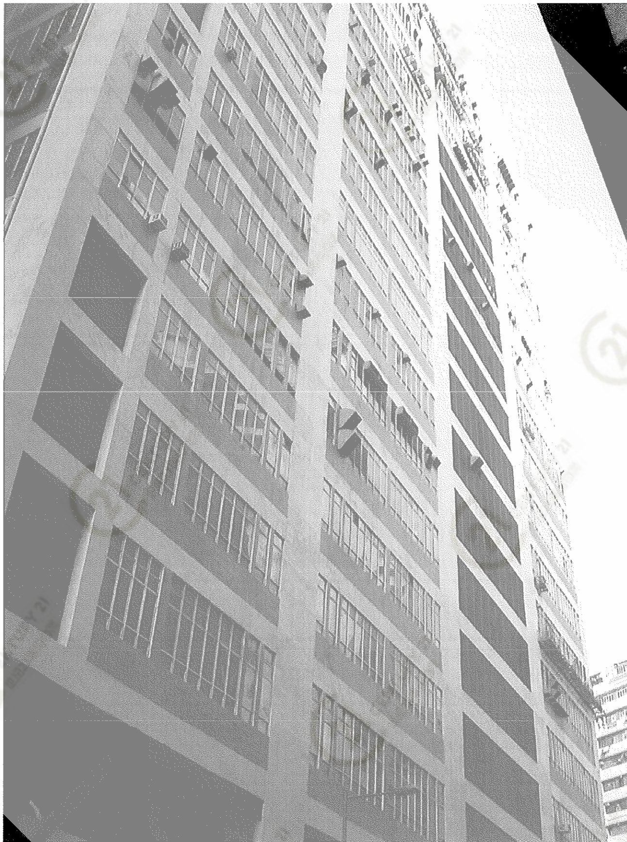
長豐工業大廈 Cheung Fung Industrial Building
