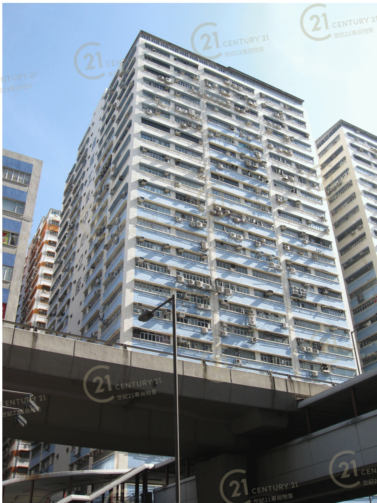
金龍工業中心2座 Golden Dragon Industrial Centre Block 2
