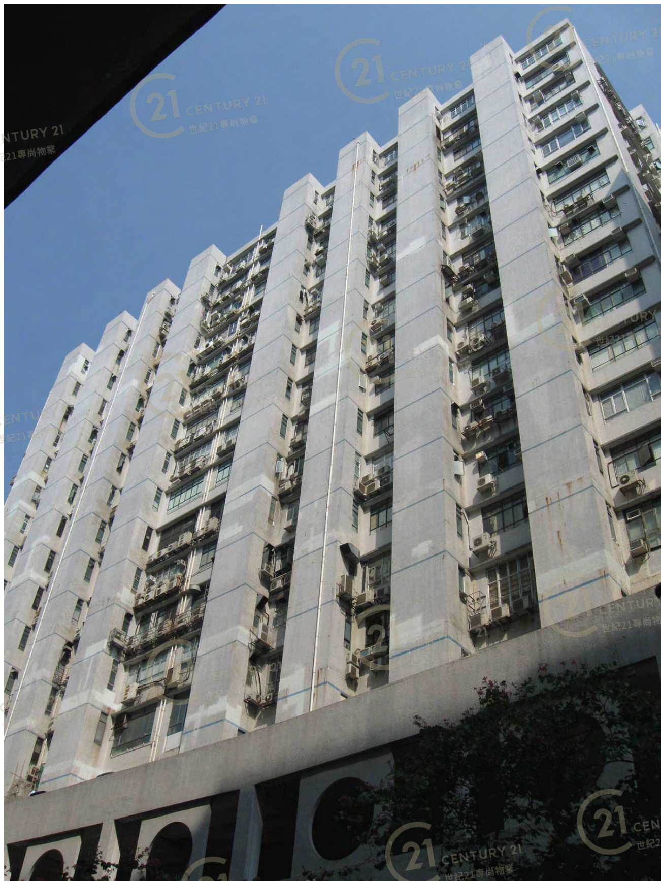
華衛工貿中心 Wah Wai Industrial Centre
