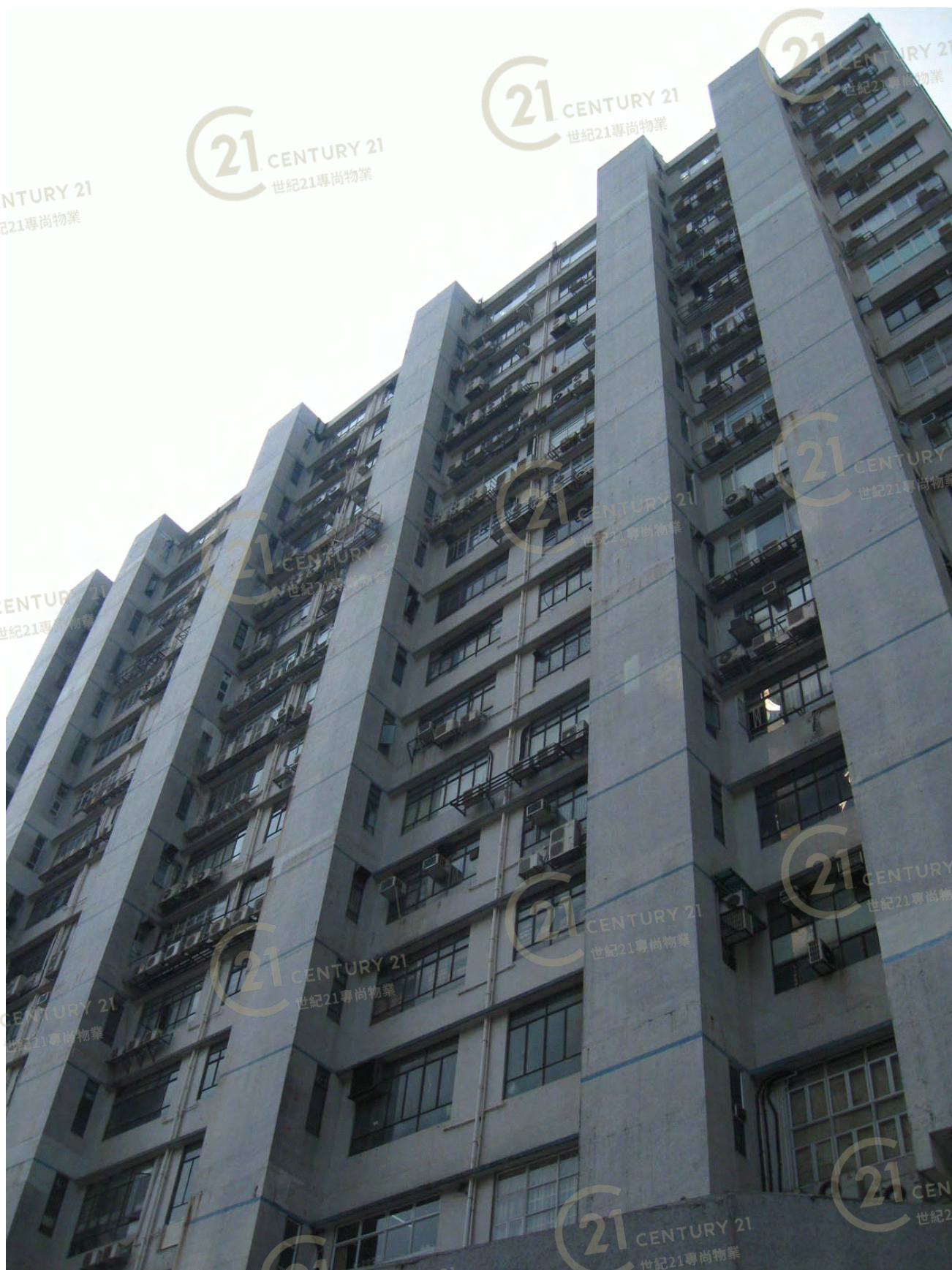
華衛工貿中心 Wah Wai Industrial Centre
