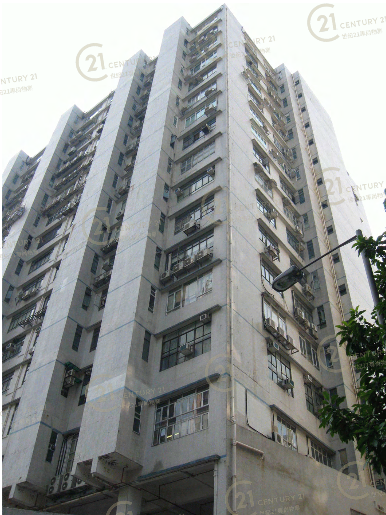
華衛工貿中心 Wah Wai Industrial Centre
