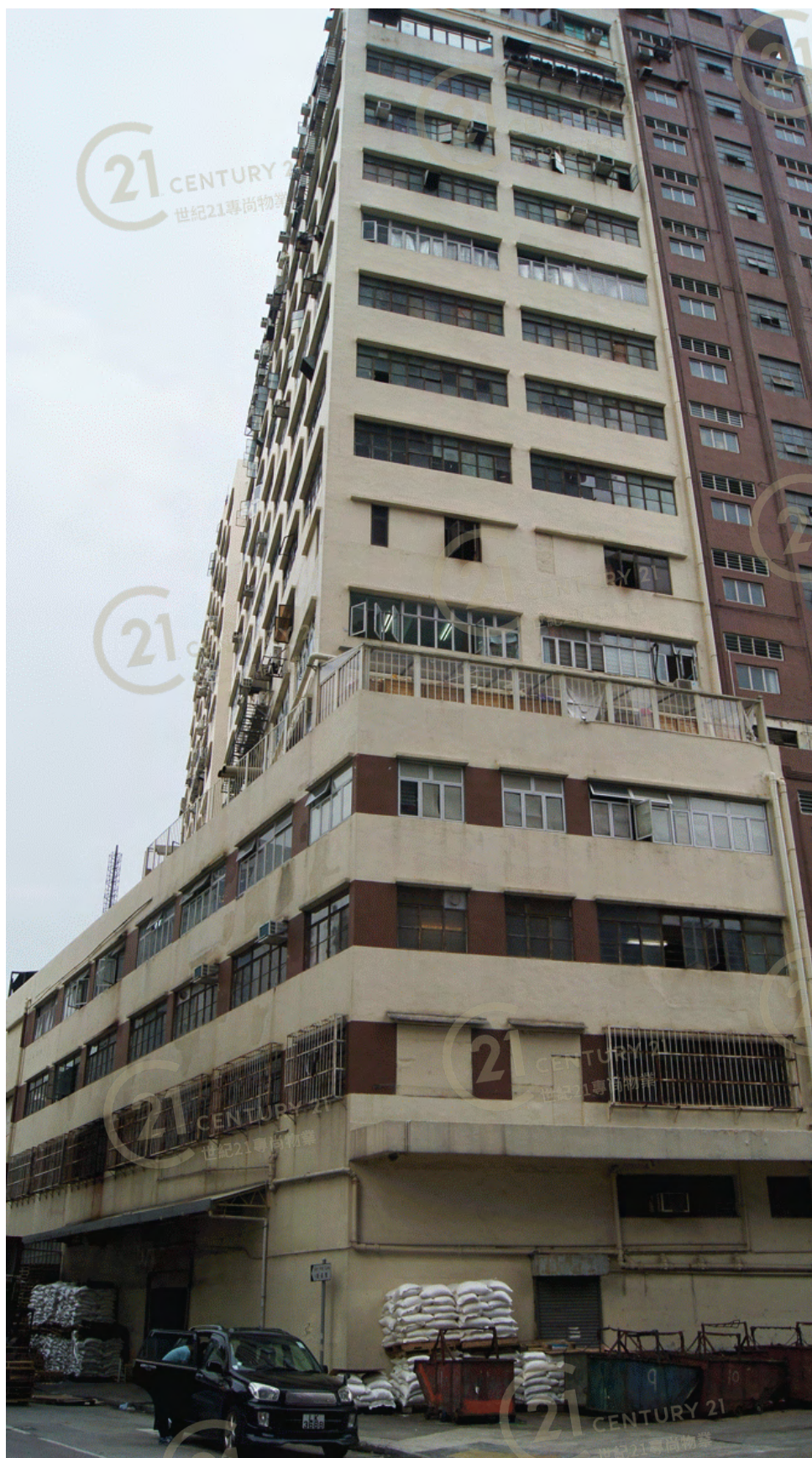
屯門工業中心C座 Tuen Mun Industrial Centre Block C
