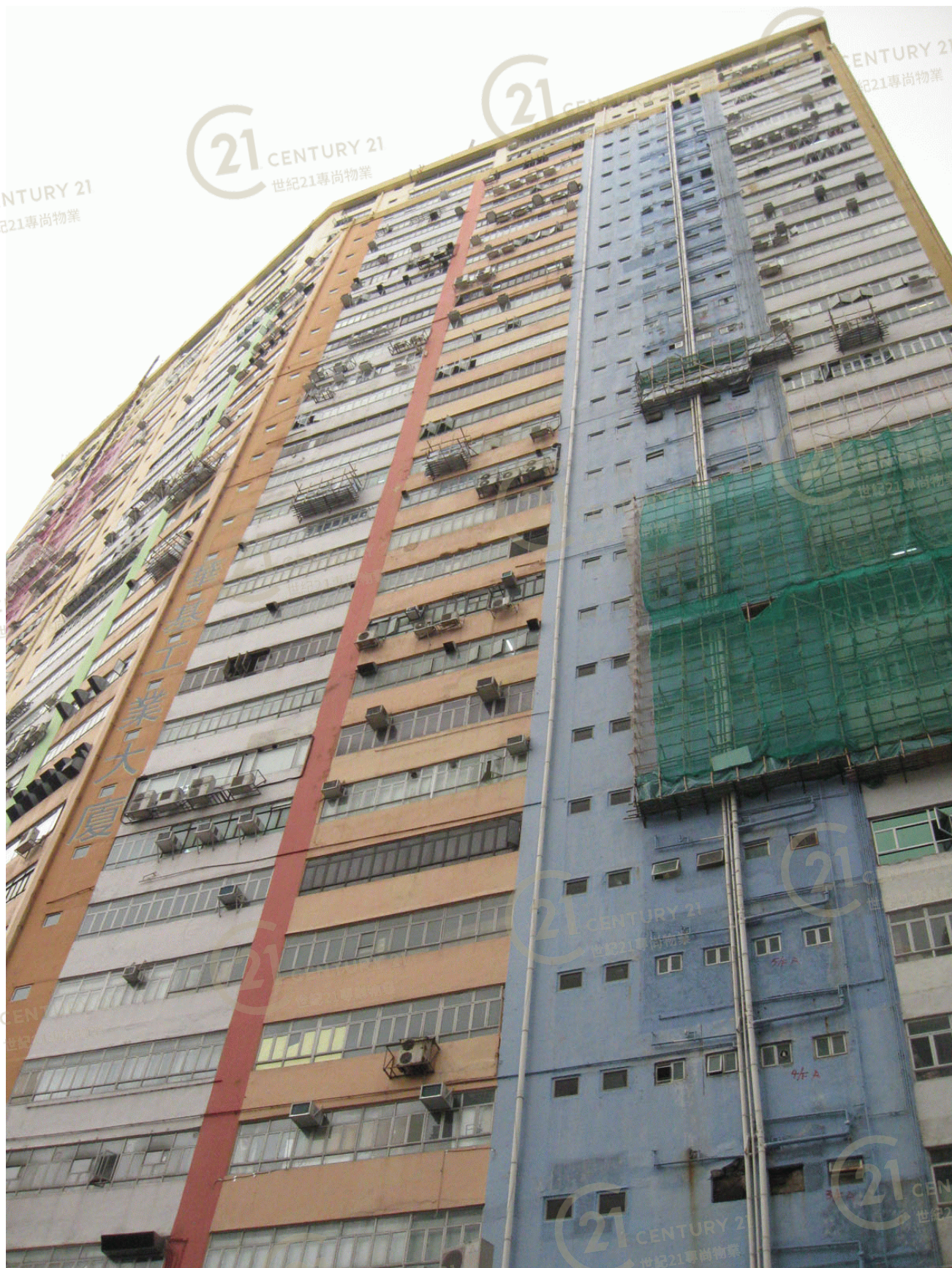
華基工業大廈1座 Vigor Industrial Building Phase 1
