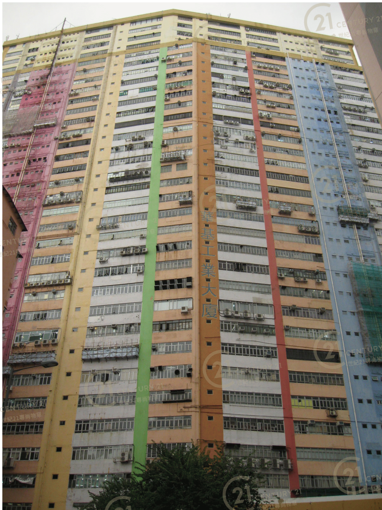
華基工業大廈1座 Vigor Industrial Building Phase 1
