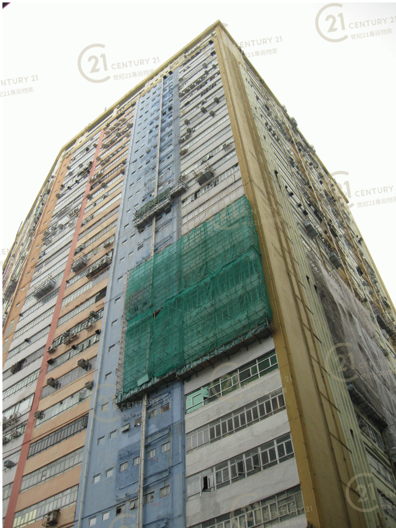
華基工業大廈1座 Vigor Industrial Building Phase 1
