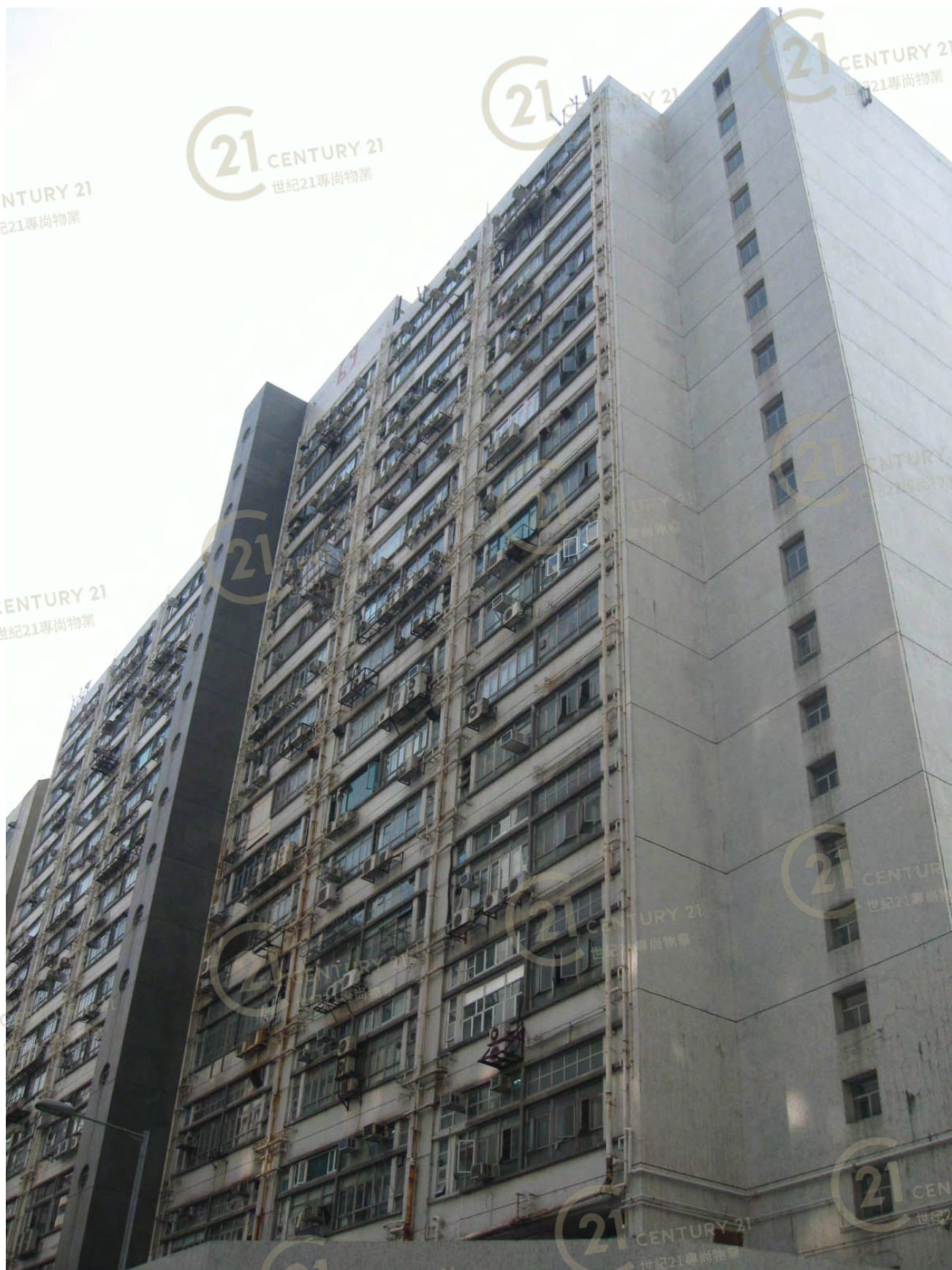
盈力工業中心 Yale Industrial Centre
