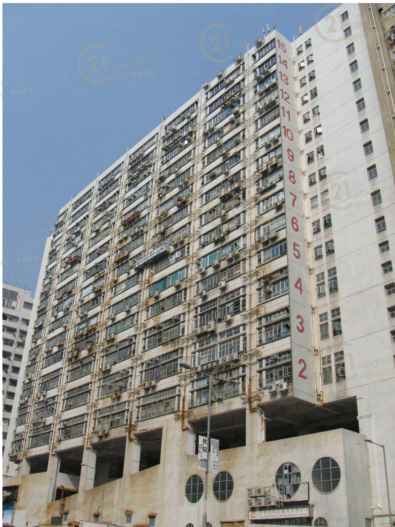
盈力工業中心 Yale Industrial Centre
