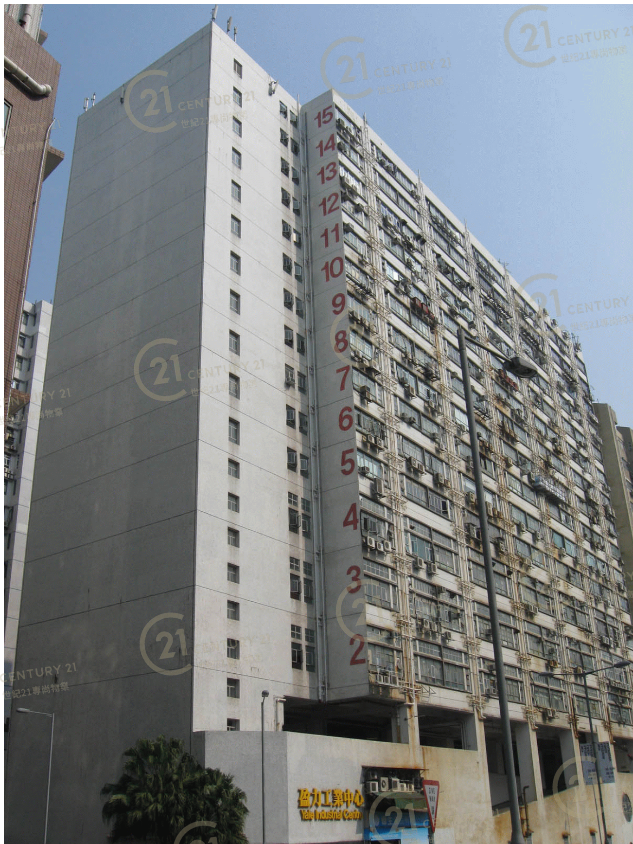
盈力工業中心 Yale Industrial Centre
