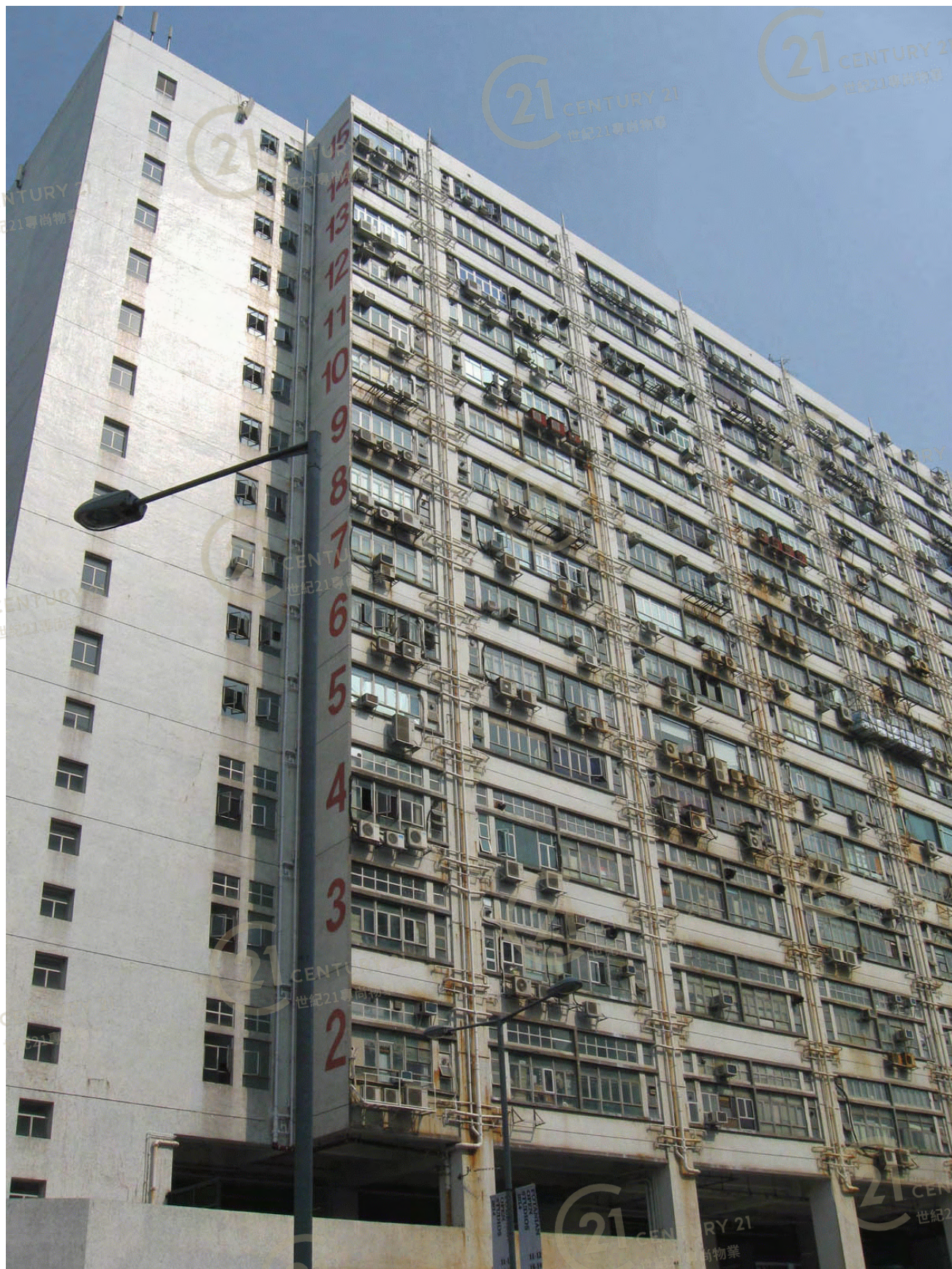
盈力工業中心 Yale Industrial Centre
