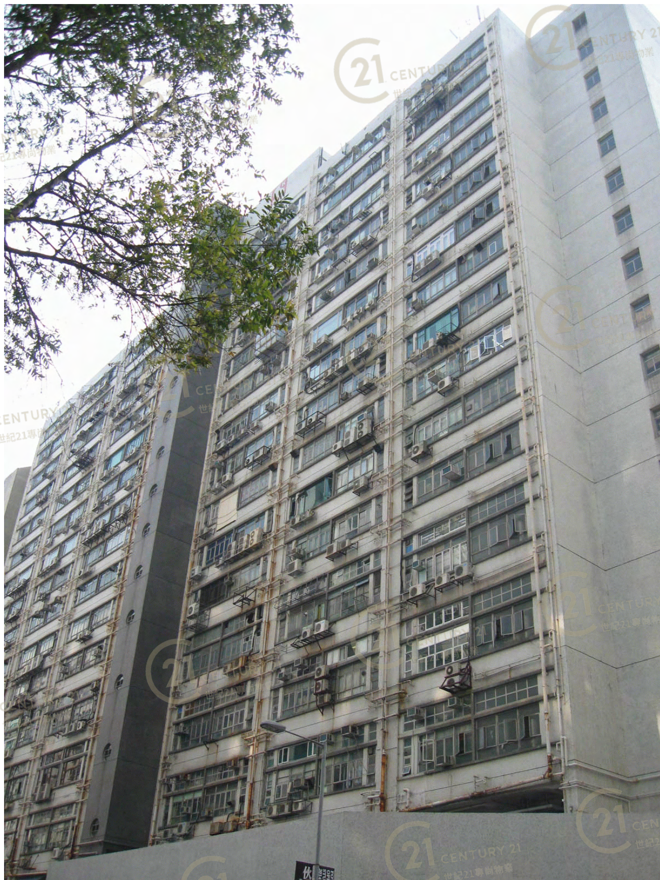
盈力工業中心 Yale Industrial Centre
