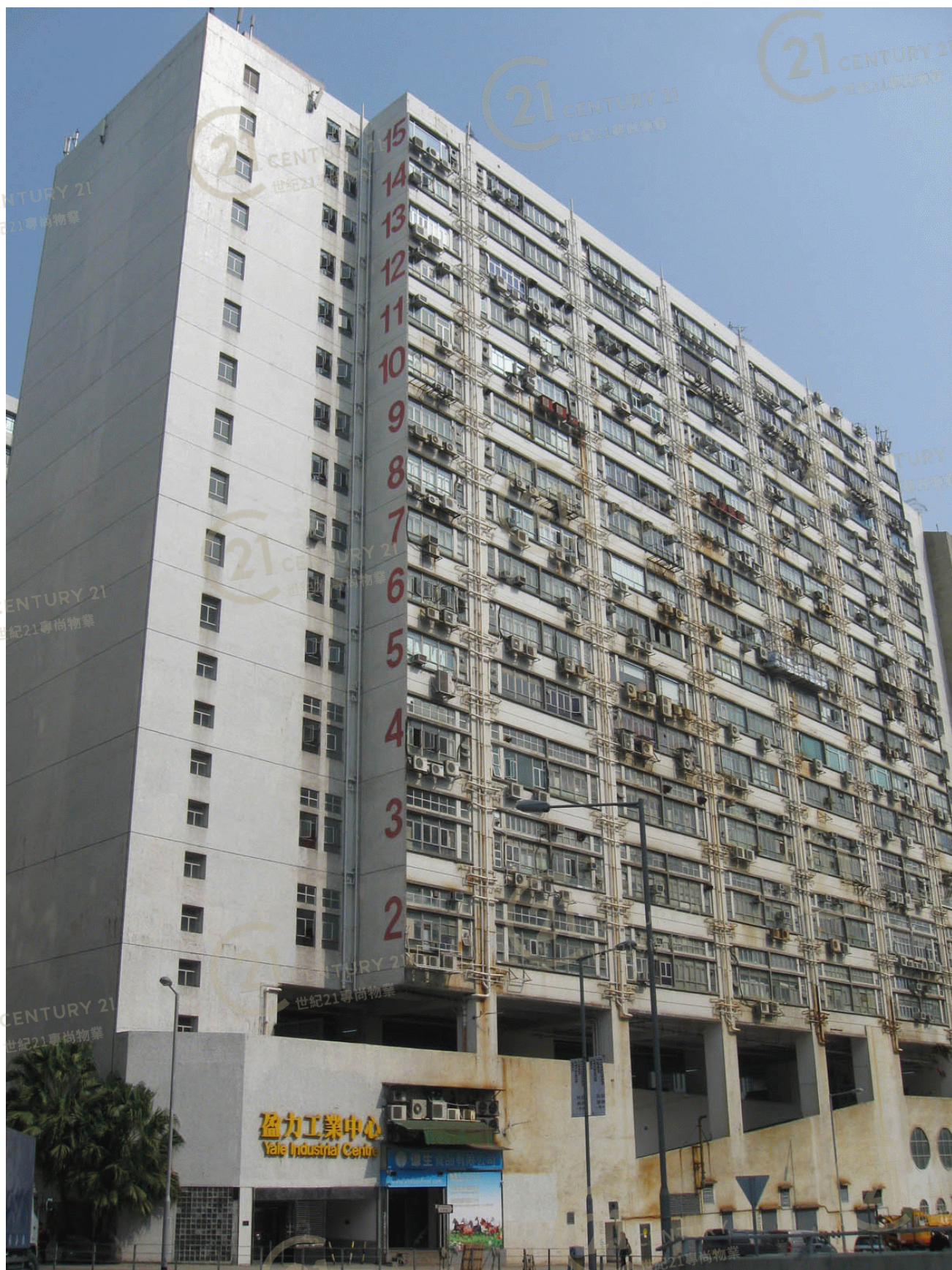
盈力工業中心 Yale Industrial Centre
