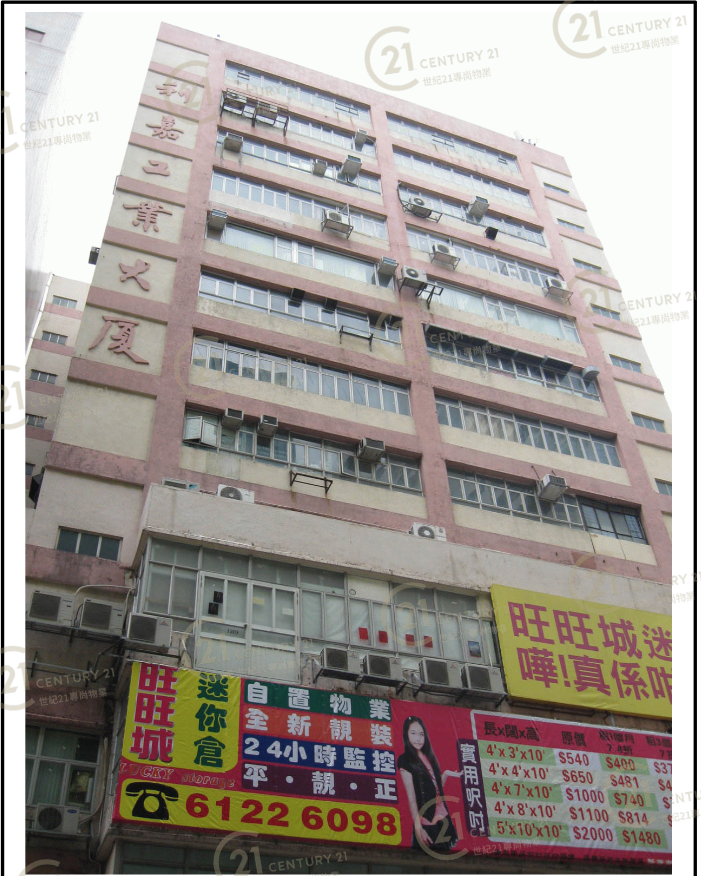
利嘉工業大廈 Lee Ka Industrial Building
