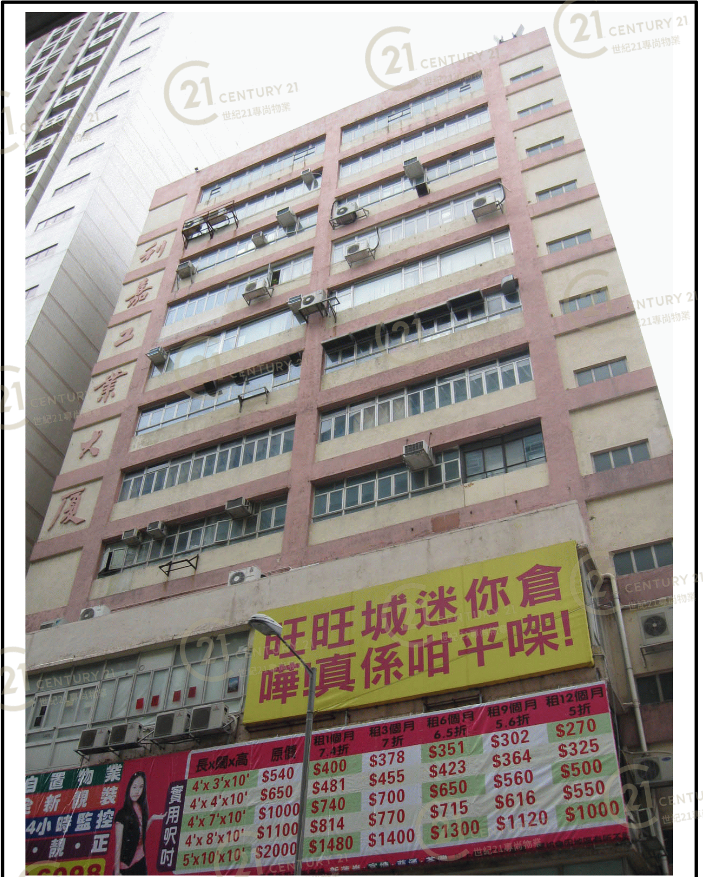
利嘉工業大廈 Lee Ka Industrial Building
