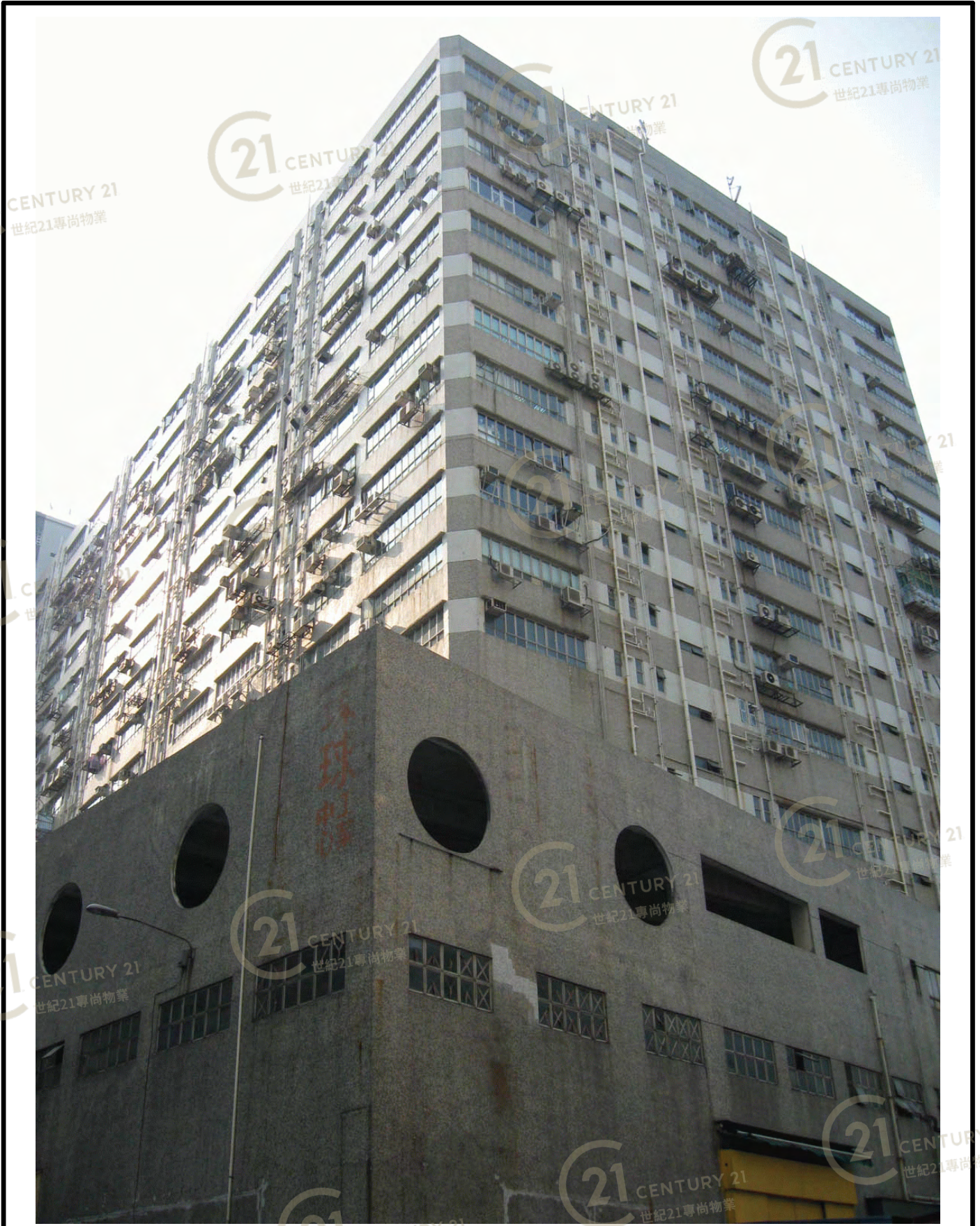
環球工業中心 World-Wide Industrial Centre
